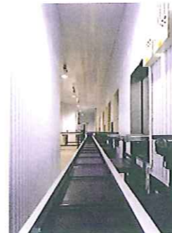
自動倉庫型保管庫
